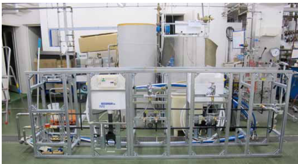
Fig. 1: Messaufbau im SVGW-Labor. Im Hintergrund Druckminderer, Wassermesser und Wassererwärmer. Im Vordergrund Stockwerkverteilung bestehend aus Badewanne, Doppelwaschtisch, WC, Dusche, WC, Waschtisch, Waschautomat und Küche mit Geschirrpüler.
